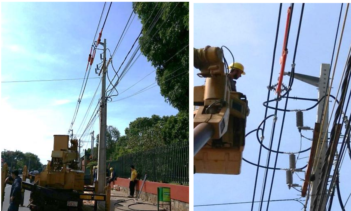
Construcción de Nuevos Alimentadores de Media Tensión emergentes del Futuro Centro de Distribución Fernando de la Mora, Distritos de Fdo. de la Mora y Asunción- Licitación Pública Nacional ANDE N° 1222/2016 – BONOS I
